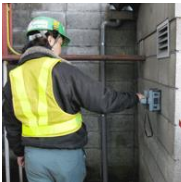
配筋状況調査
