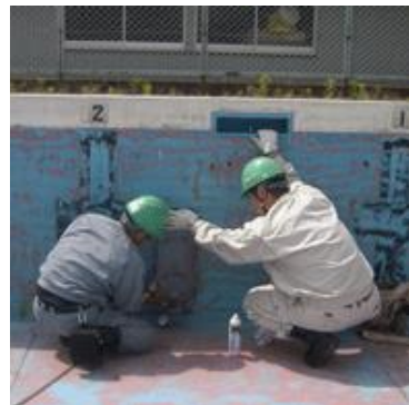
漏洩調査風景
