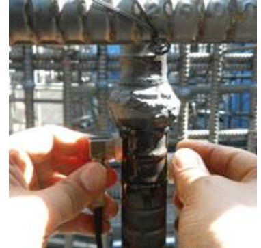
鉄筋ガス圧接部検査風景
