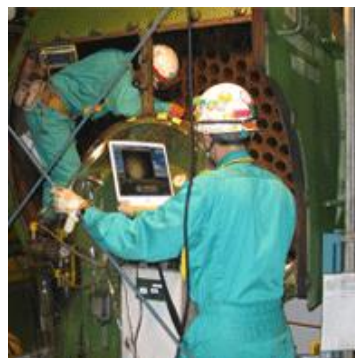
ボイラ焼管の肉厚測定
