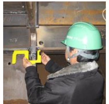
仕口のずれ確認
