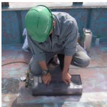
漏洩調査風景
