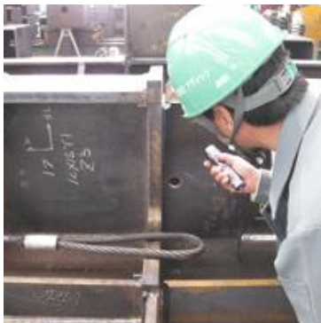
外観目視検査
