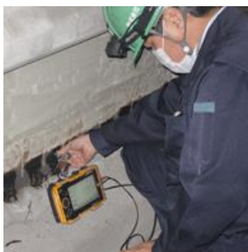
鋼製構造物厚さ測定風景
