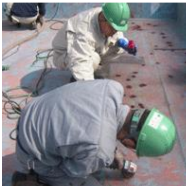
漏洩調査風景
