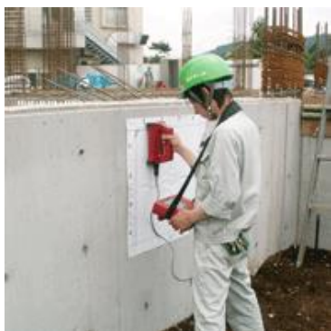
電磁誘導探査風景
