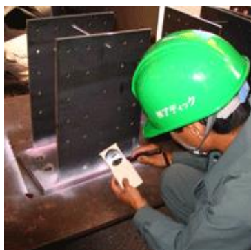
浸透探傷検査風景
