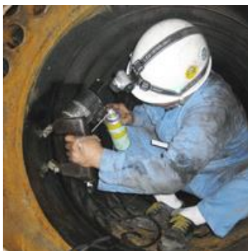
ボイラ内部磁粉探傷検査
